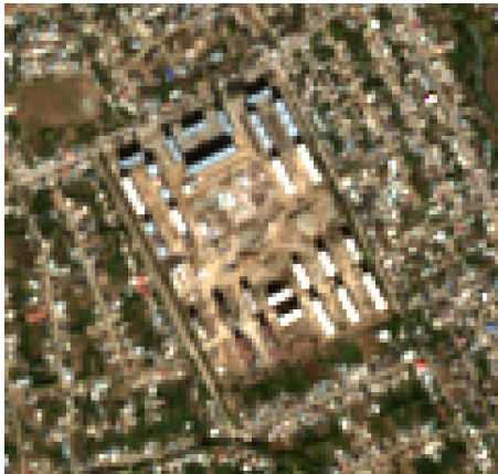
10.2026 каркасы без кровли
